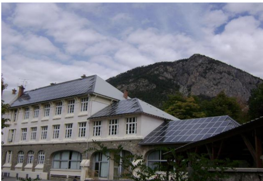
Centrale photovoltaïque de 33kWc sur le toit de l'école de Mi-chaussée à Briançon
