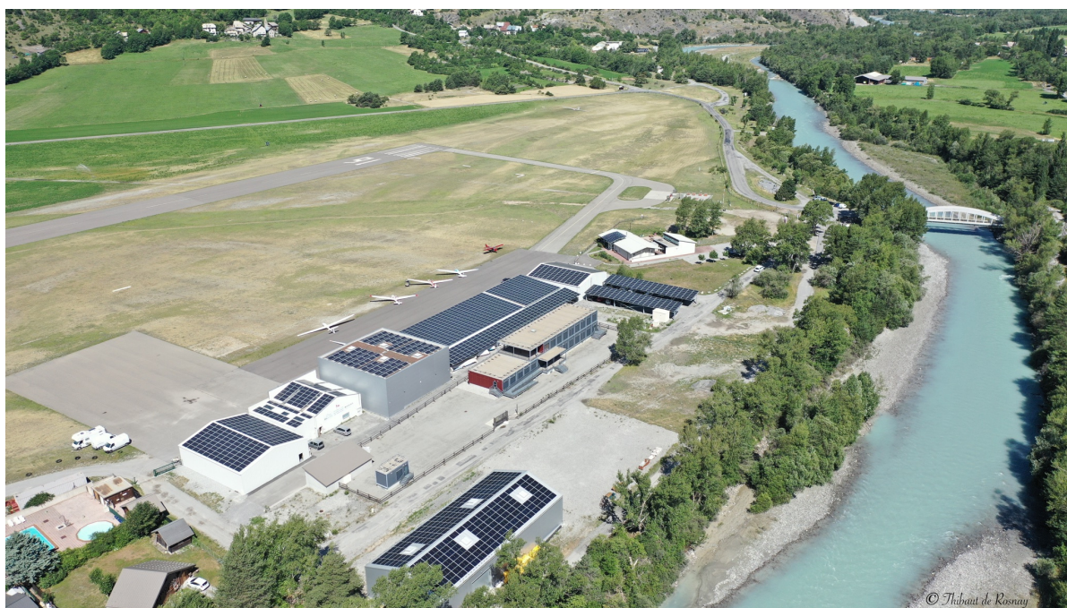
Installation photovoltaïque sur l'aérodrome de Saint Crépin
