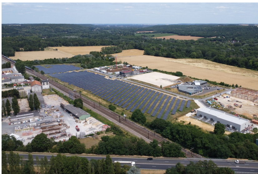
La parc photovoltaïque au sol installé sur la ZAC des Hautes Prasles à Étréchy, codéveloppé par Energie Partagée et la SEM SIPEnR
