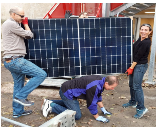
Figure 1: Stockage des panneaux en vue de l'installation de la centrale de la Fraternité
