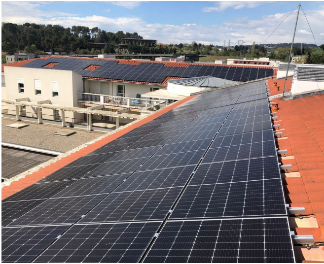
Figure 3: Centrale PV de l'EHPAD
